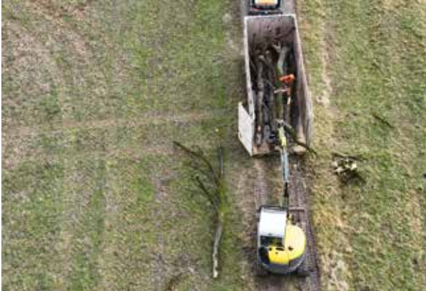
Roman Deringer mit dem Bagger und Andrin Stadler mit der Motorsäge sorgen für eine kompakte Beladung.
