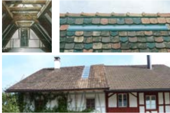
Beispiele für Dachflächenlichtbänder
