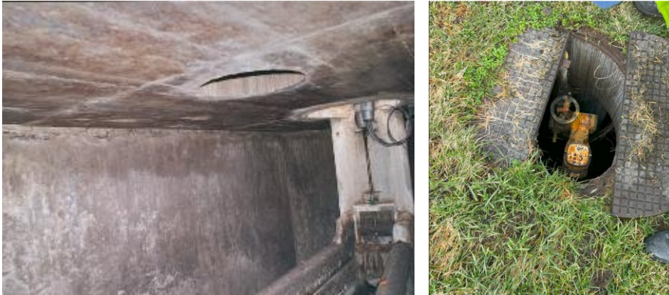
Bild 2: Drosselbauwerk mit Überfällen und Motorschieber
