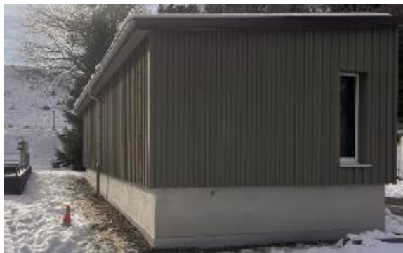
Bild 9: Referenzbild Pumpwerk ARA Schönenberg, vorvergraute Holzschalung und Innenbild Holzschalung auf Betonsockel.
