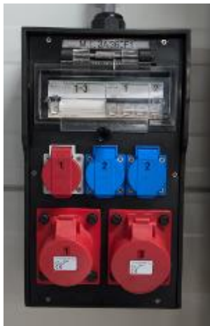
Bild 38: Bsp. Steckdosenverteiler
