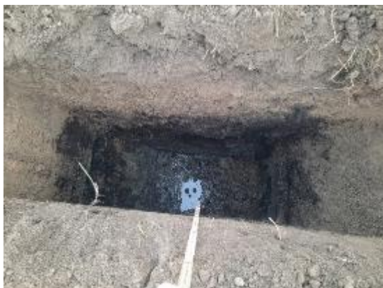
Bild 45: Sondage Nr. 1: bindiger Boden
