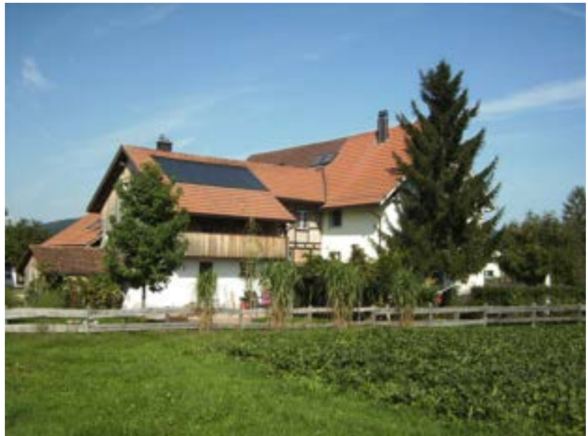
Solaranlage in Waltalingen
