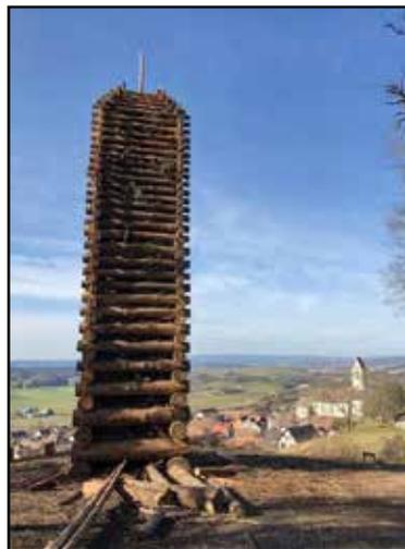
Es ist ein Holzturm aus Holzstämmen. Aus immer zwei parallelen Stämmen, die abwechselnd quer und längs platziert werden, wachsen diese Holztürme immer dünner werdend in die Höhe.
